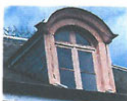
Lucarne demi-ronde charpentée
